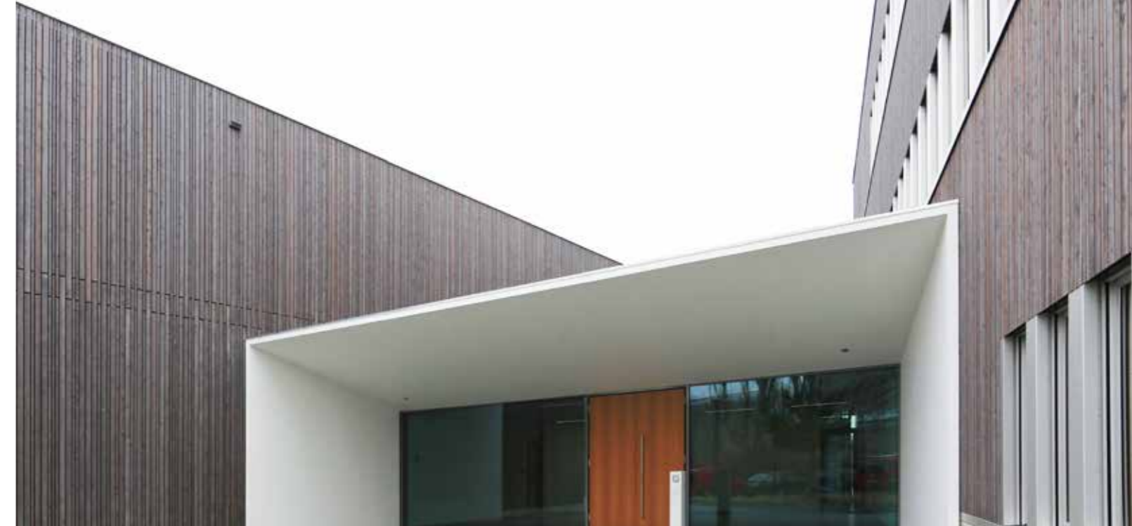
Eingangsbereich des 2021 fertiggestellten »Zentrums für leichte und umweltgerechte Bauten ZELUBA®« in Braunschweig.
